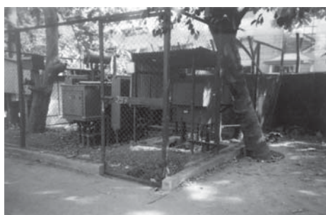
Рис. В39: Подстанция наружной установки без корпуса
