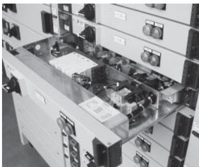
Рис. Е32 : РУ с выдвижными функциональными блоками
