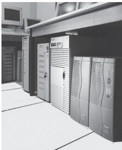
Рис. М30б: Блок ИБП, повышающий надежность (готовность) и качество электропитания компьютерной системы
